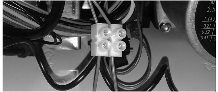
Рис. 5. Доступ к клеммной колодке
